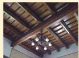
Modrzewiowy strop na piętrze zamku
